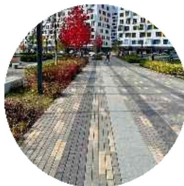
Тротуарная плитка одного формата, но разных цветов и укладки
